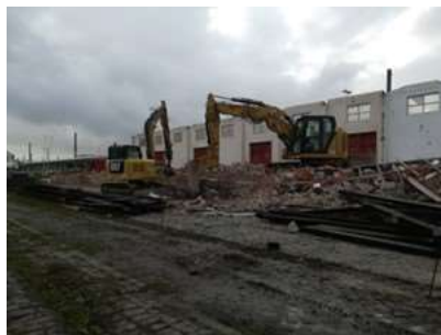
Fig. 5.4.8. - Demolição de casas e cais coberto na Estação de Braço de Prata.
