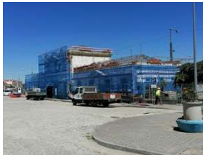
Fig. 5.4.6. - Estação de Vila Franca das Naves
