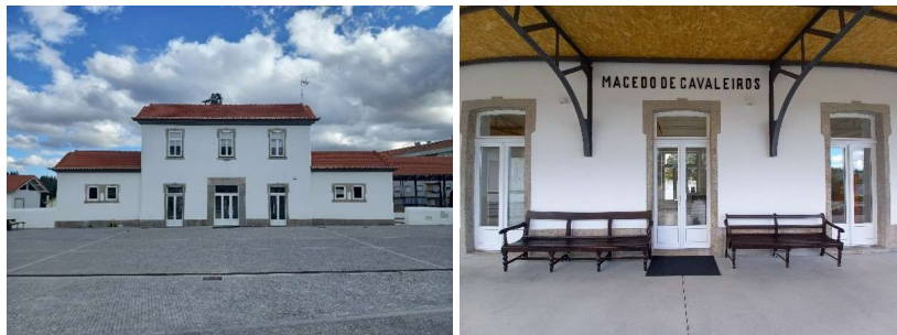
5.1.1.2. Estação de Macedo de Cavaleiros após recuperação (Fonte: IPP)
