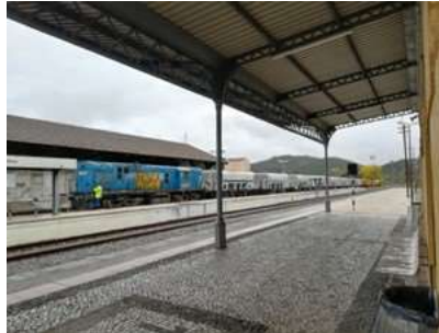
Fig. 5.4.3. - Estação de Torres Vedras
