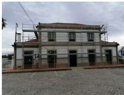
Fig. 5.4.4. - Estação de Carregal do Sal
