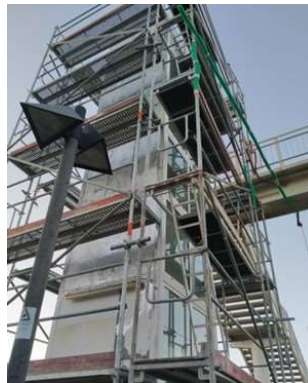
Fig. 5.4.7. - Reabilitação das torres dos elevadores do Apeadeiro de Sacavém
