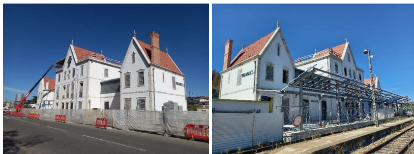
5.1.1.3. Estação de Mirandela em obra (Fonte: IPP)
