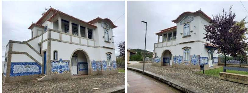
5.1.1.1. Estação de Mondim de Basto após recuperação (Fonte: IPP)
