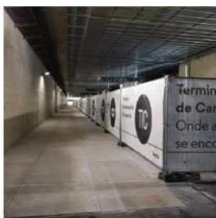
Fig. 5.4.13. - Obra no TIC promovida pela Câmara Municipal do Porto
