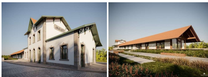
5.1.1.4. Estação de Mirandela em obra (Fonte: IPP)
