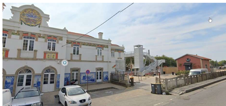
5.1.6. Estaleiro da empreitada de modernização da L. do Norte – Granja
