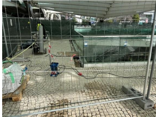
Fig. 5.4.29. Estação de Gare do Oriente
