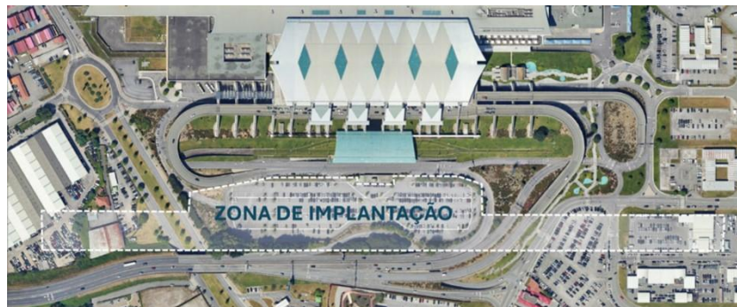
Fig. 5.4.6. Estação do Aeroporto Sá Carneiro
