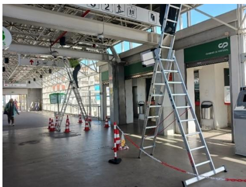
Fig. 5.4.33. Estação da Póvoa de Santa Iria
