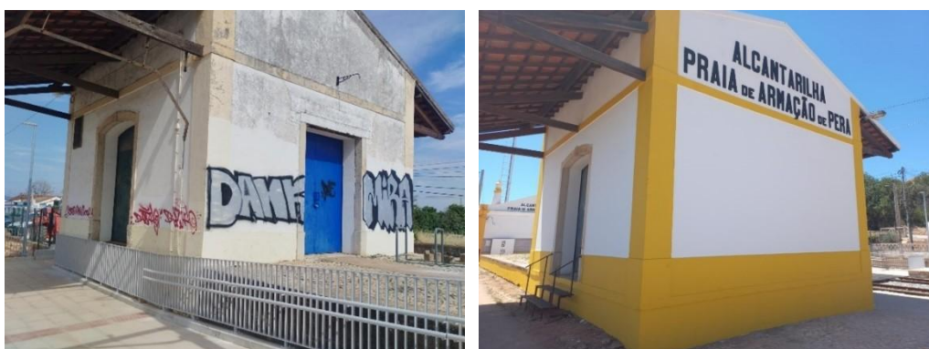
Fig. 5.4.42. Estação de Alcantarilha, snack bar, antes e depois
