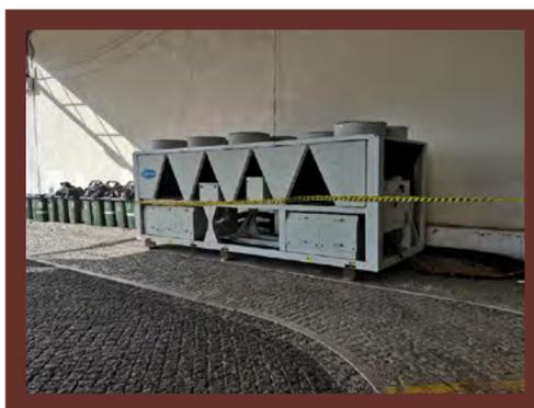
Fig. 5.4.19. Rossio- Instalação de sistema provisório de ar condicionado
